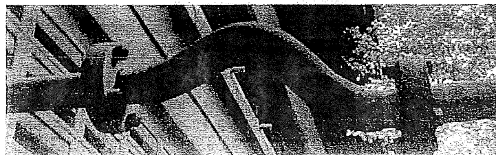
ภาพแสดงลักษณะ Flexible Hose ที่มีการบิดงอผิดรูปแบบ อันเกิดมาจากการทรุดตัวที่ไม่เท่ากันของท่อ
